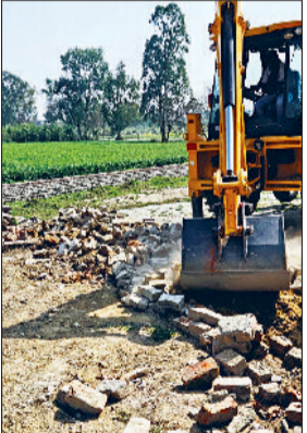
अंबाला। अवैध कॉलोनिजियों में हुए निर्माण को ढहाती जेसीबी।
